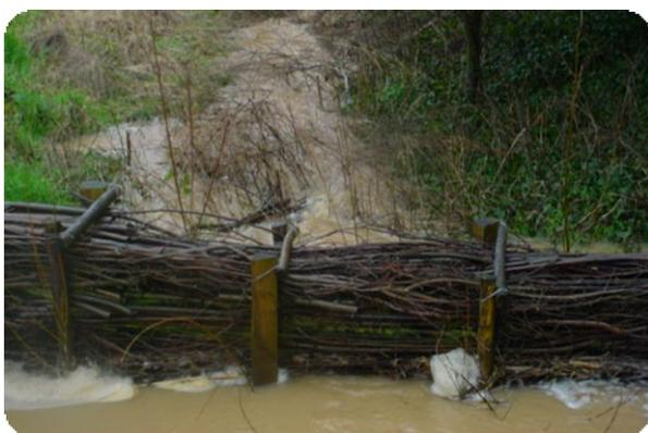
*Réalisation d'aménagements de haies et de fascines sur l'ensemble du bassin versant menés par l'EPTB afin de limiter l'érosion des sols.*
