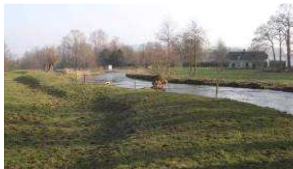
Figure 33 : Merlon de curage sur la Varenne
