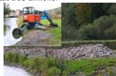
Figure 9 : 2 exemples de curage et rectification
