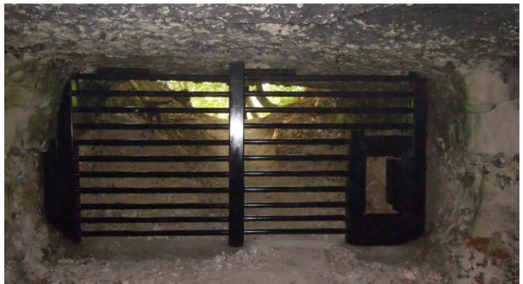
FIGURE 8: EXEMPLE D'UNE PROTECTION PHYSIQUE D'UNE CAVITE D'hibernation de chauves-souris à SAINT-LEONARD/76 (©GMN)
